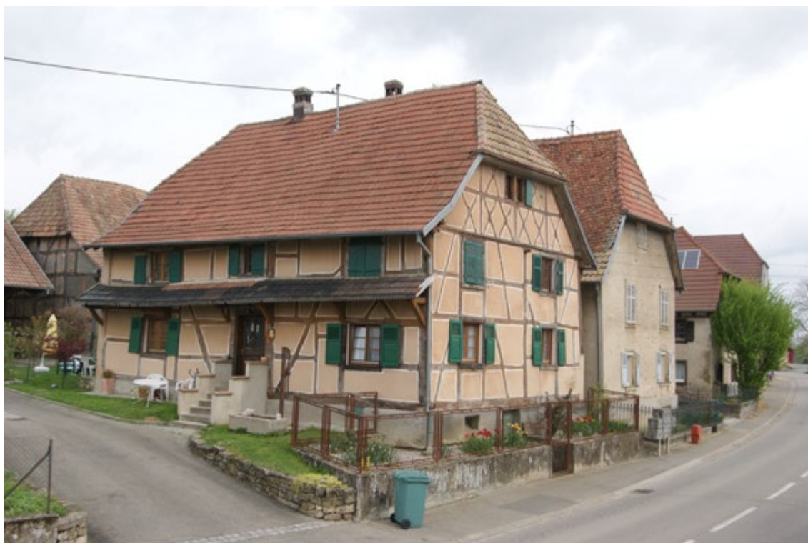
FIG. 1 : Wolfersdorf : la maison de 1551 (crépi gris au centre) en contexte, de nos jours. De gauche à droite, au fond grange de 1561, maison de 1564, maison de 1551 et au fond à côté de l'arbuste maison de 1586. Un paysage villageois du XVI e siècle quasiment intact (© M. Grodwohl)
