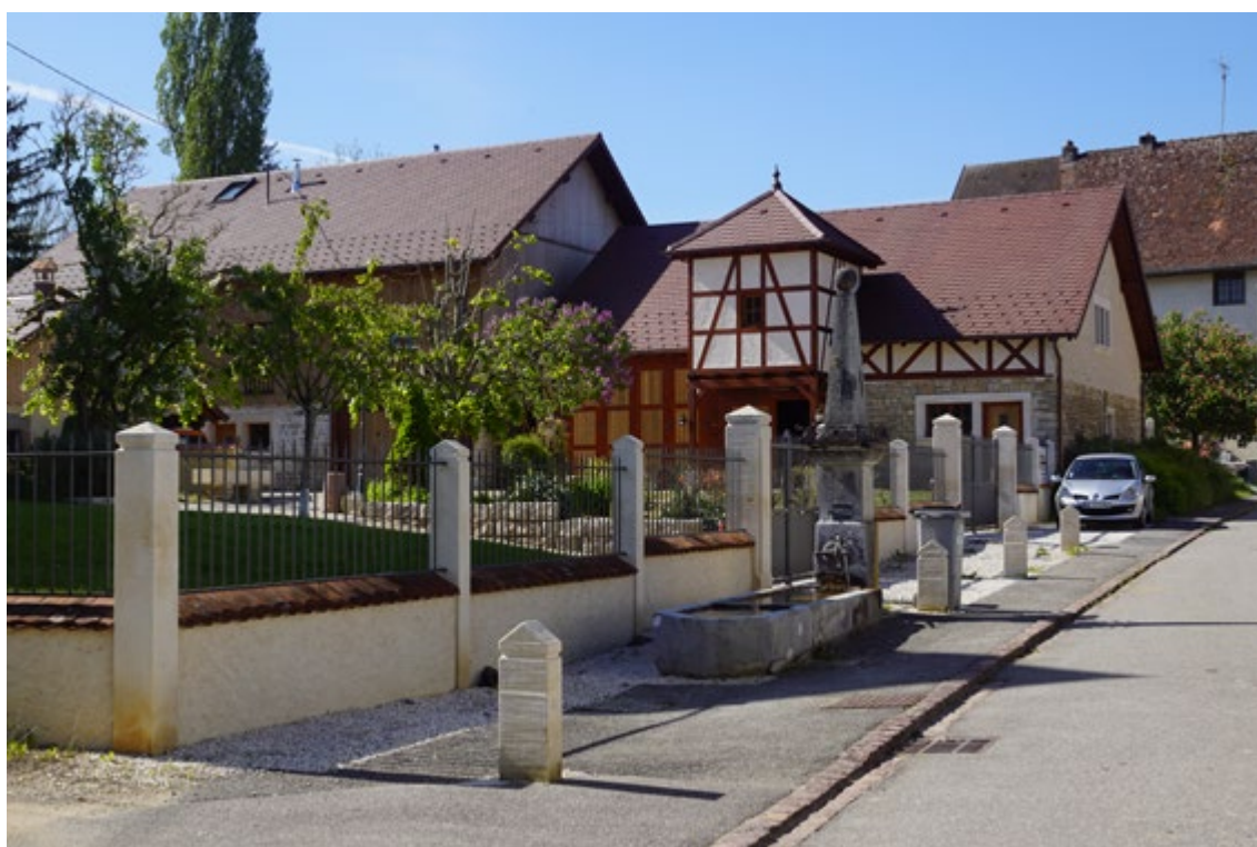
FIG. 11 : La fontaine où la famille Sanner abreuvait ses vaches et à l'arrière-plan la « castellisation » de l'ancien hangar de ferme (© M. Grodwohl, 2019)
