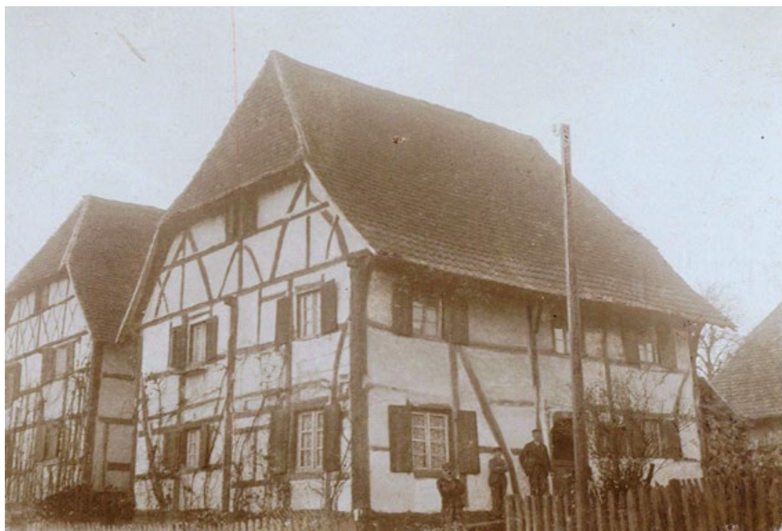
FIG. 2 : Wolfersdorf : la maison de 1551 au début du XX e siècle (© M. Grodwohl)
