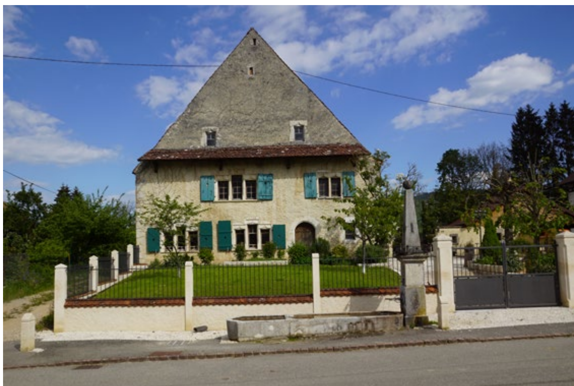
FIG. 10 : Le « Tribunal » est encore dans son état après restauration par « Maisons paysannes d'Alsace », 40 ans après ces travaux. Mais il est à présent enclos (© M. Grodwohl, 2019)
