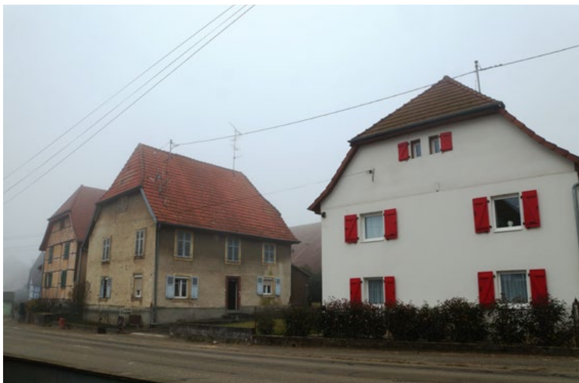
FIG. 6 : Wolfersdorf : au premier plan maison datée 1586, après isolation par l'extérieur (© M. Grodwohl)
