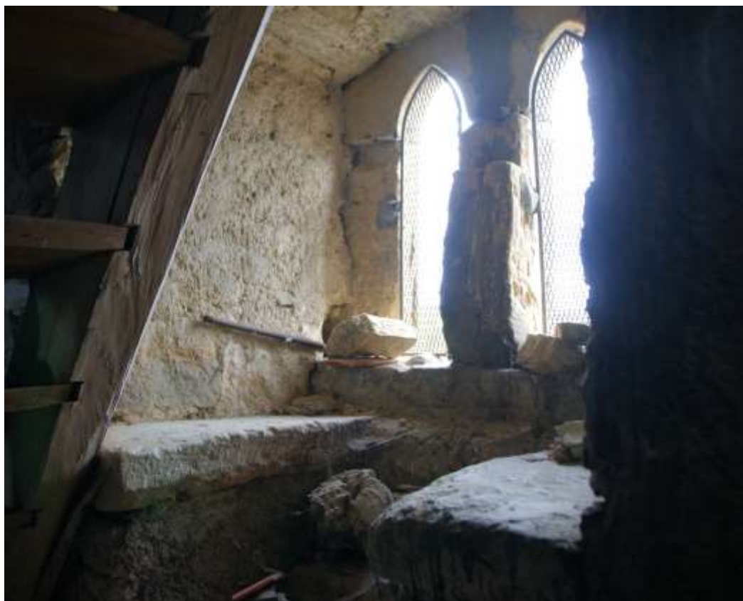
Figure 25. Fenêtre géminée à banquettes pratiquée dans le mur sud de la salle du premier étage
