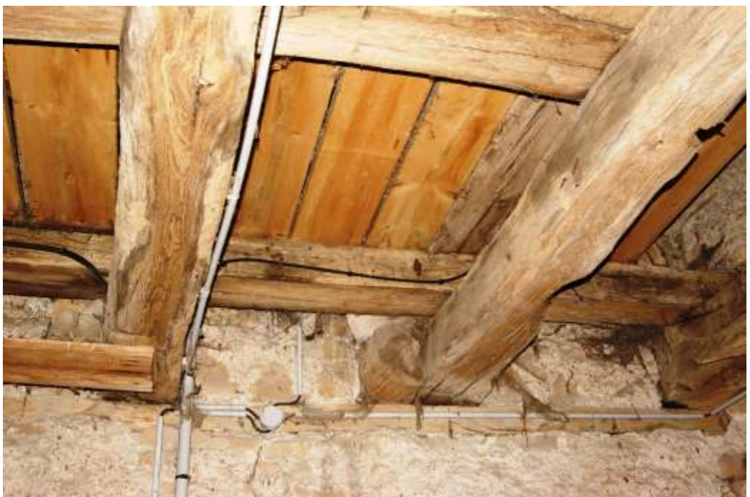
Figure 27. Solivage de la salle du second étage montrant, à côté des solives du plafond, les solives de support du plancher du hourd prises dans la maçonnerie et de ce fait conservées, tous ces éléments datés 1267
