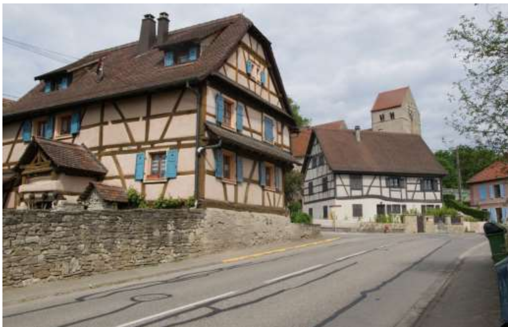
Figure 6. Au second plan, 23 rue principale, vu depuis le sud, marque l'angle présumé de l'enclos ecclésial . On distingue l'épaisse poutre sablière qui, normalement correspond à la fondation de la maison et qui ici se retrouve à l'étage, probablement du fait de la suppression de la plate-forme.
