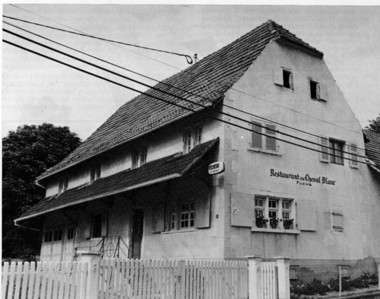
La maison Fuchs à Koetzingue a conservé certaines de ses ouvertures, ainsi que l'auvent d'origine (XVI e siècle).
